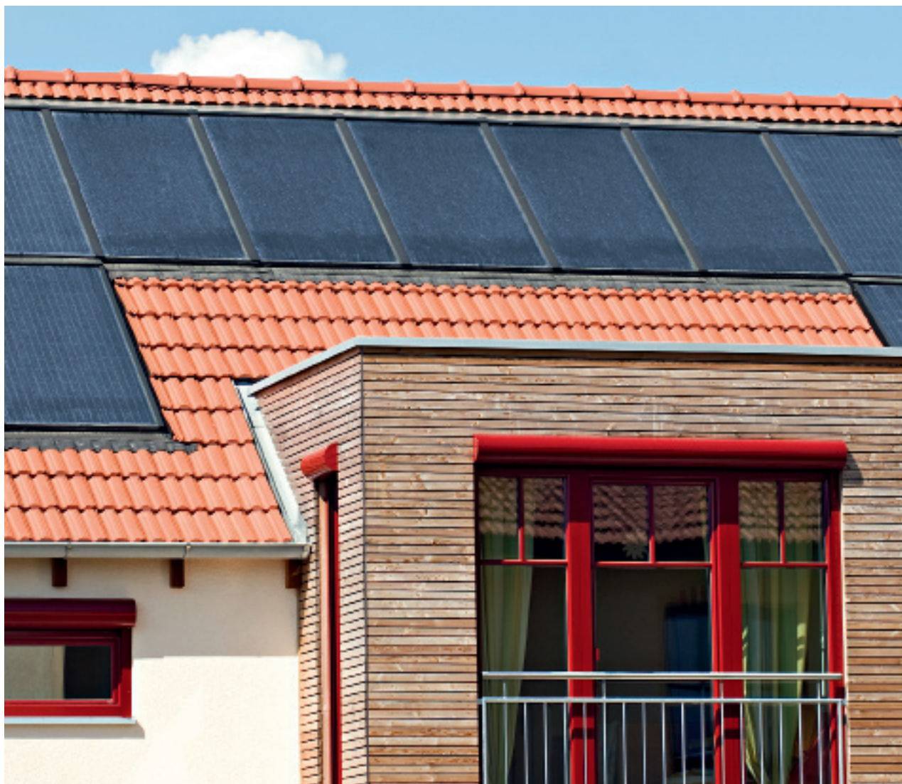
Dom mieszkalny w Nandlstadt – instalacja solarna 10,6 m 2 do podgrzewania wody użytkowej oraz wspomagania ogrzewania w połączeniu z 3,2 kWh Photovoltaik
